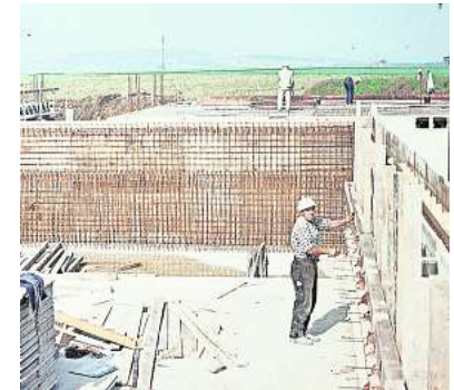
Der Bau des Schwimmbades dauerte etwa zwei Jahre. Hier entsteht das Schwimmerbecken.
